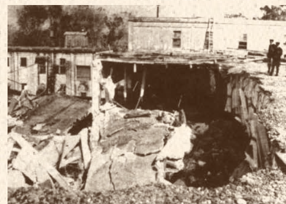
製材工場因一樓結構較不堅固而於中埔大地震當中坍塌。
